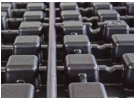
Los tubos se insertan en las guías y se conectan al dispositivo de control.
